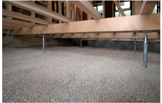
床下材施工例:木造新築住宅(コンクリートベタ基礎)
